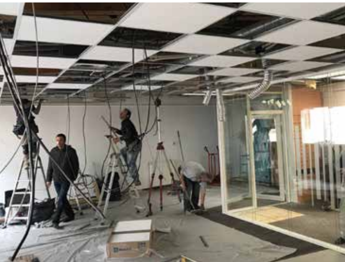
Travaux de l'agence d'Hennebont
